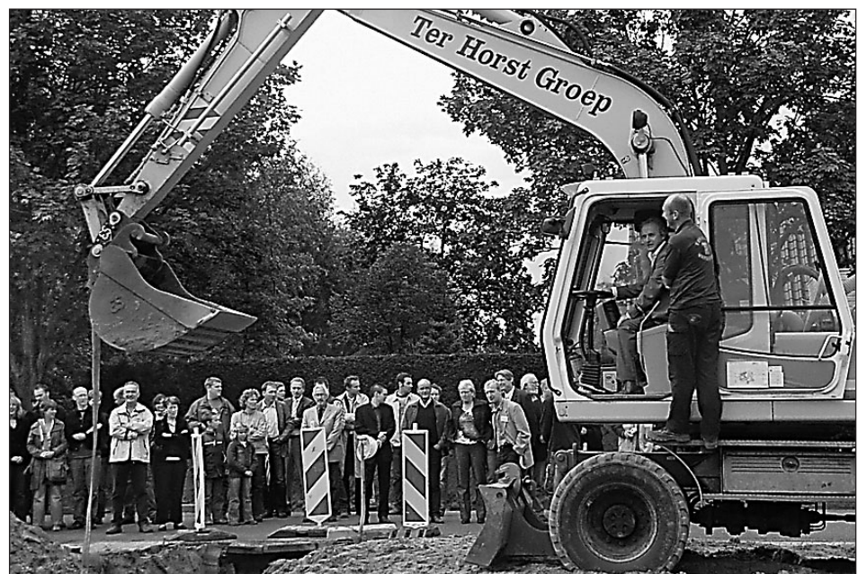
• Wethouder Haverdij verrichtte woensdag 30 augustus persoonlijk de eerste grondwerkzaamheden voor de Riezegraaf in Ulf. Hier komen 38 woningen: 6 vrijstaande, 6 twee-onder-een kap woningen, 11 geschakelde eengezinswoningen en 15 multifunctionele geschakelde woningen
