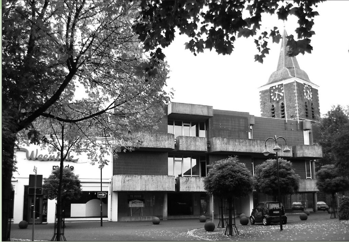
• Het pand van de voormalige modezaak Weenink dat door de gemeente is aangekocht
