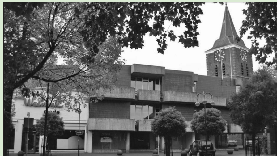
• De asbestsanering in pand Weenink is vorige week begonnen. Meteen daarna gaat het machinale sloopwerk van start.
