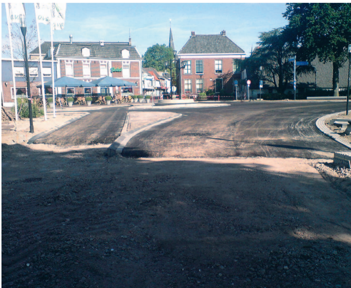
De werkzaamheden aan de kruising Anholtseweg – Grotestraat – Oranjesingel zijn bijna afgerond
