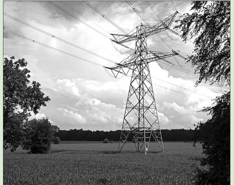
• Er is nog geen tracé vastgesteld voor de hoogspanningskabel. De gemeenten Oude IJsselstreek en Doetinchem pleiten beide nadrukkelijk voor ondergrondse aanleg.
