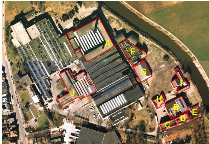
Figuur 2: Recente situatie DRU Uift, met in rood aangegeven de beschermde objecten.
