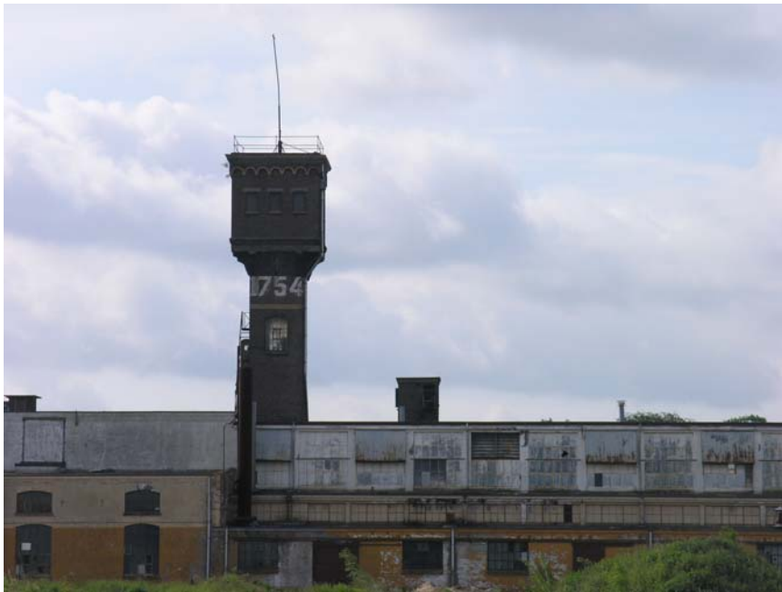
Foto 7: zicht op de watertoren
