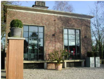
1: Voormalig transformatorhuis, nu winkel.
